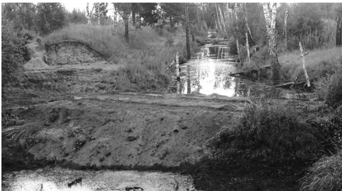
Фото строящегося подпорного сооружения при обводнении выработанного торфяного месторождения Большое Урсово Владимирской области
